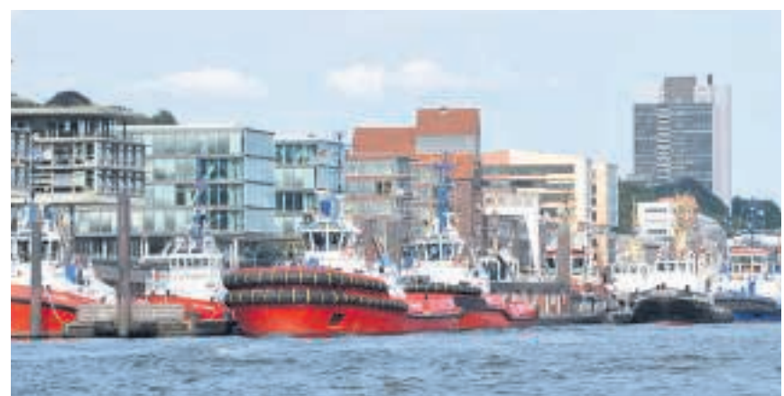
Schlepper vor der Kulisse von Büro- und Wohngebäuden der Großen Elbstraße
